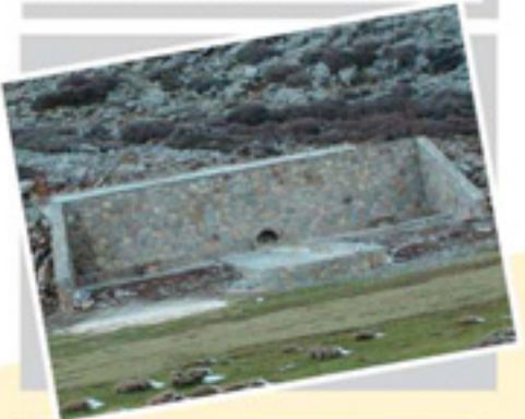
Ομβροδεξαμενή στα Πετραδολάκια
