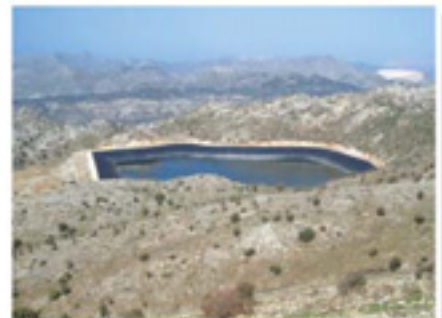
Λιμνοδεξαμενή στο Γωνομίο
