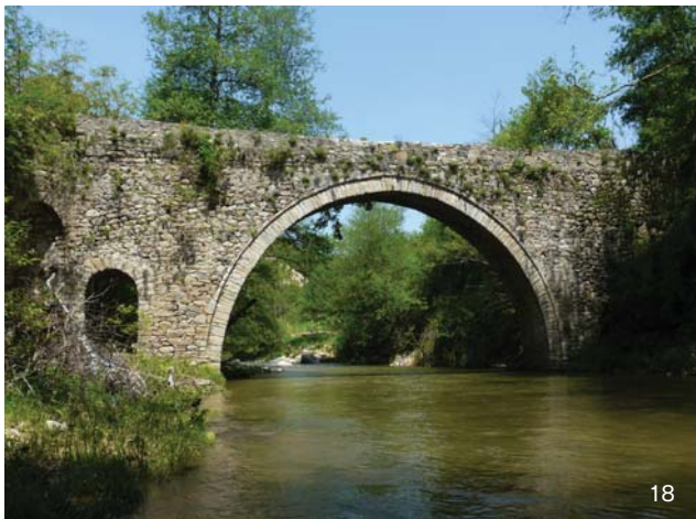
18. Η γέφυρα του Παππά
